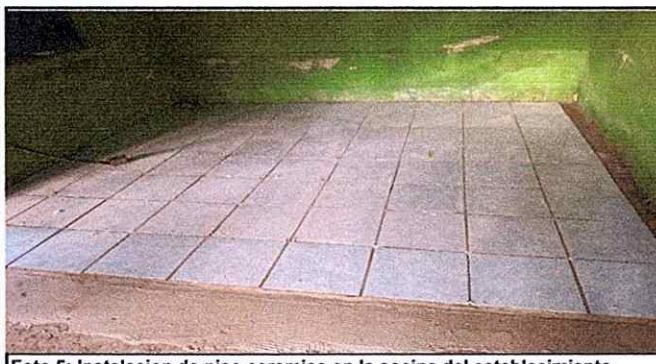
Foto 5: Instalacion de piso ceramico en la cocina del establecimiento educativo
