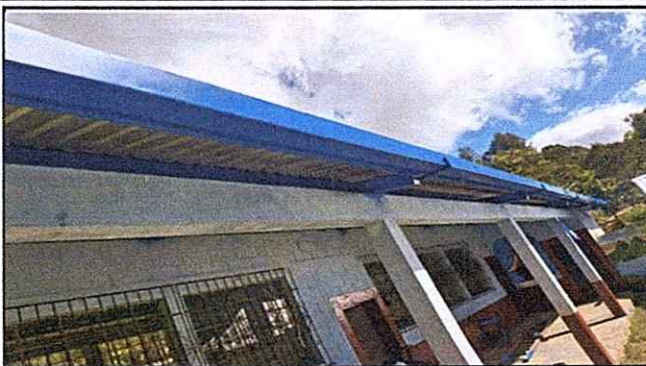
Foto 8: Instalación de canales para mejorar la captación de agua pluvial.
